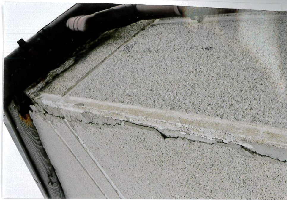
Fot. 10. Spękania narożnika południowo-wschodniego korpusu.
